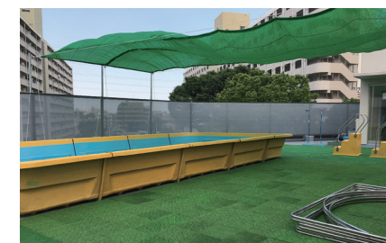
遮光用のネットの設置など敷設工事を行っている
