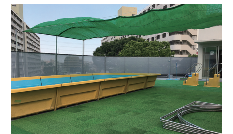
遮光用のネットの設置など敷設工事を行っている
